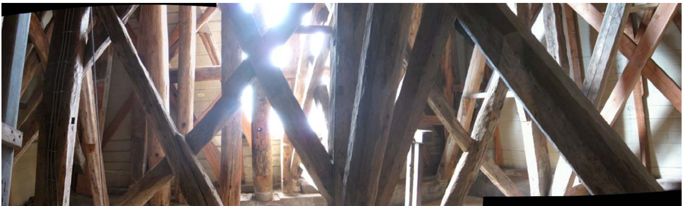
Er is in de loop van bijna 500 jaar al heel wat aan de toren en de inwendige houtconstructie gerepareerd en versterkt. De originele houtconstructie is van eikenhout. De toevoegingen zijn meestal in grenenhout uitgevoerd.
