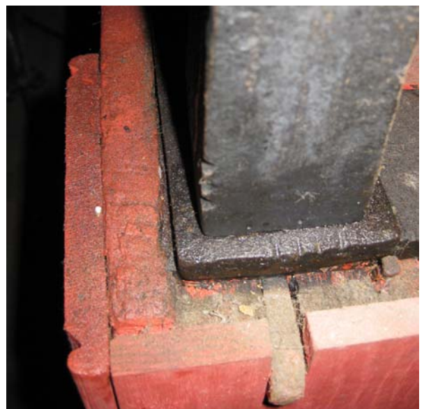
Afbeelding 31: montagemerken in stijl en in regel.
