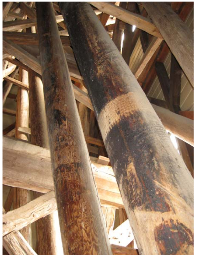
Afbeelding 9 : 18e eeuwse versterking met scheepsmasten.
