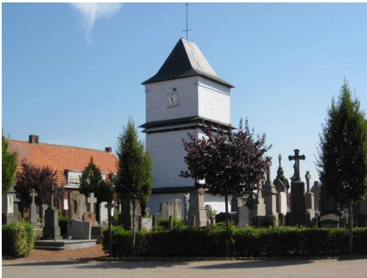
Afbeelding 44: de andere, grotere, houten klokkentoren bevindt zich in Eecke. Hier ook met een uurwerk. Dat dit soort torens niet op- maar los naast de kerk is gebouwd zou gedaan zijn uit oogpunt van brandgevaar.
