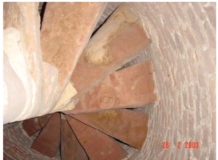
Afbeelding 17: spiltrap in de zuidelijke traptoren, met 8 treden van rode zandsteen.
