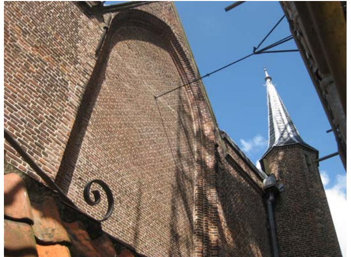
Afbeelding 40: de drijfslag van de uurwijzer van de wijzerplaat in de kerk gaat door de lucht.
