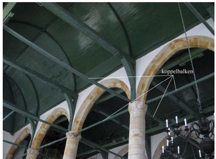
Afbeelding 13: houten gewelven en koppelbalken in twee richtingen.
