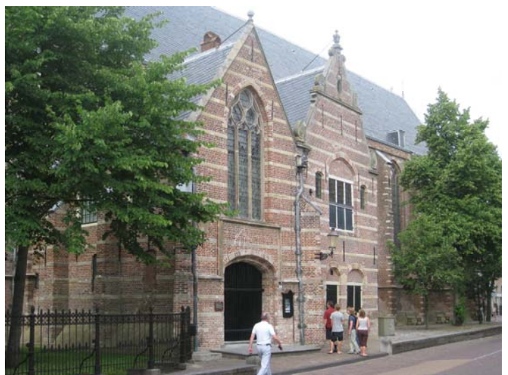
Afbeelding 44: zuidportaal met op de verdieping de kerkenraadskamer.
