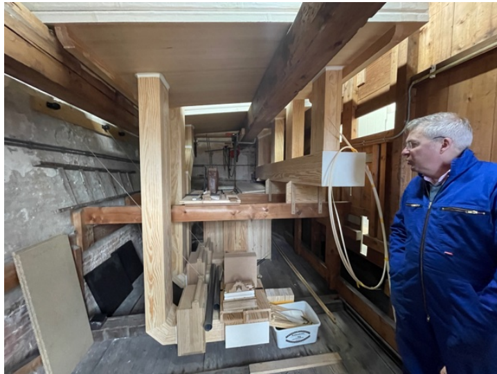
'Work in progress', werk in de balgenkamer aan de windvoorziening van het orgel. Rechts Verschuieren-directeur Johan Zoutendijk
